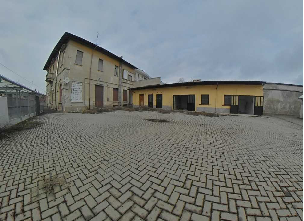
Vista dal cortile interno
