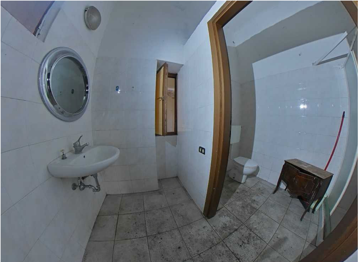
Piano primo – bagno interno all'unità abitativa
