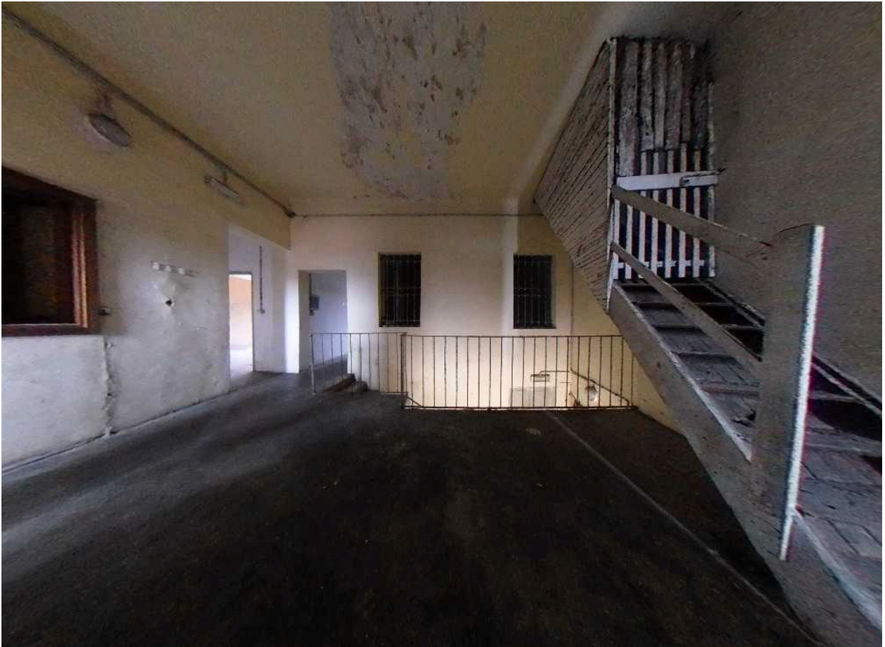
Piano primo – vano scala
