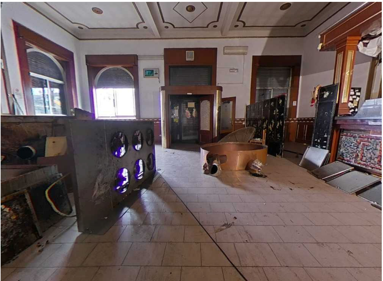
Piano terra - interno ex ristorante
