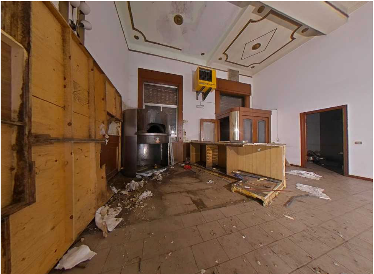
Piano terra - interno ex ristorante
