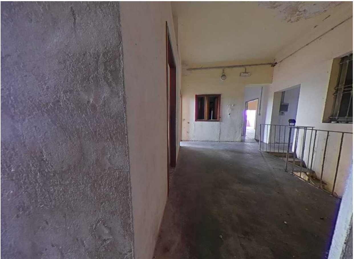
Piano primo – vano scala
